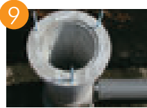
ボルトの据付
