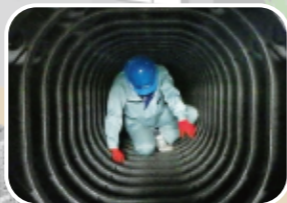
槽内点検状況
